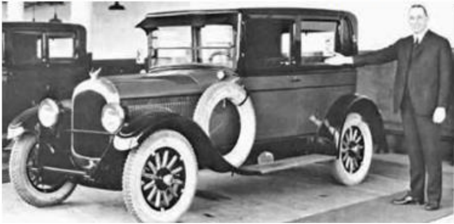
Chrysler 70 (1924. g) – prvi automobil sa hidrauličnim kočnicama
